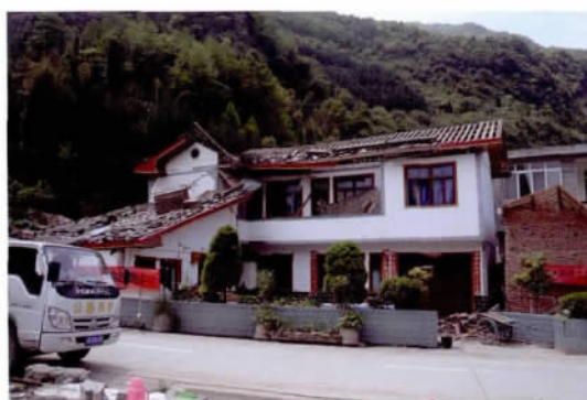
图 13 砖混结构房屋严重破坏
