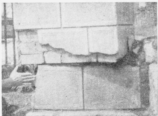
照片 4 门柱被扭剪成两段
