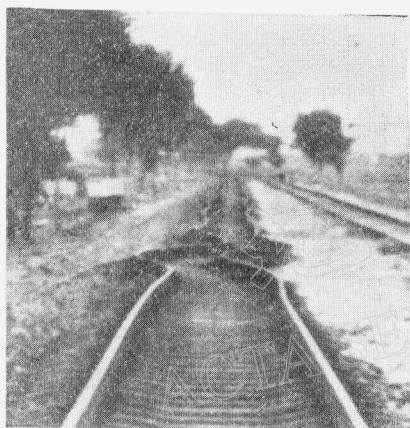
照片 2 地震的水平扭矩分量造成铁轨的扭曲
